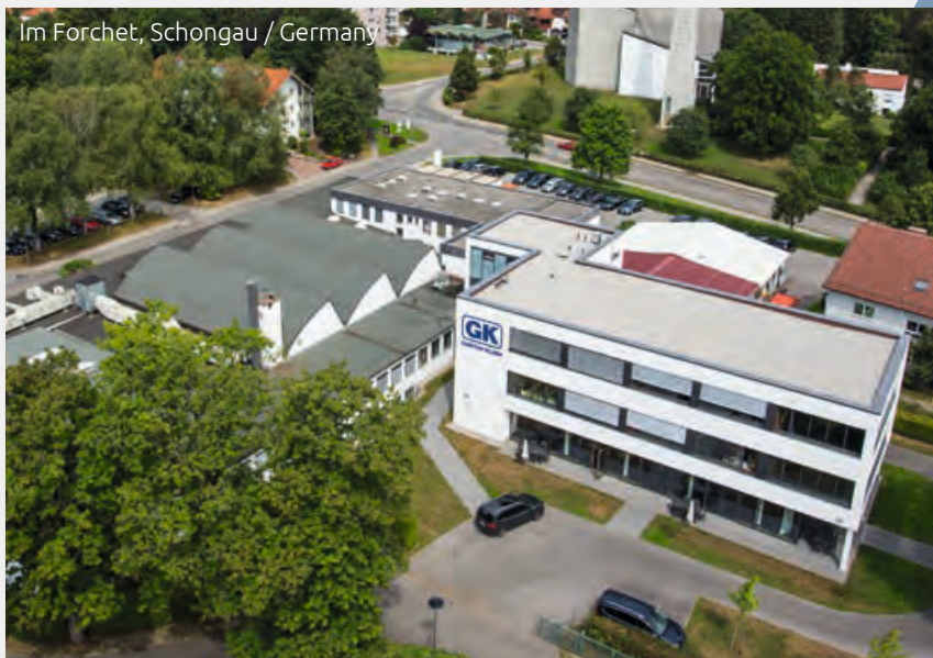
Greifenstraße, Schongau / Germany
